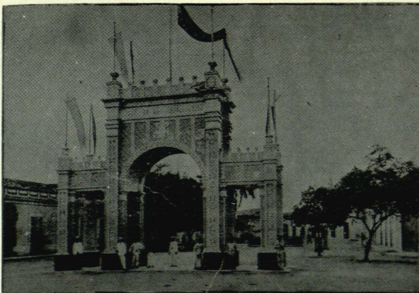
CUMANÁ—Arco de la Restauración—Fot. Avril
