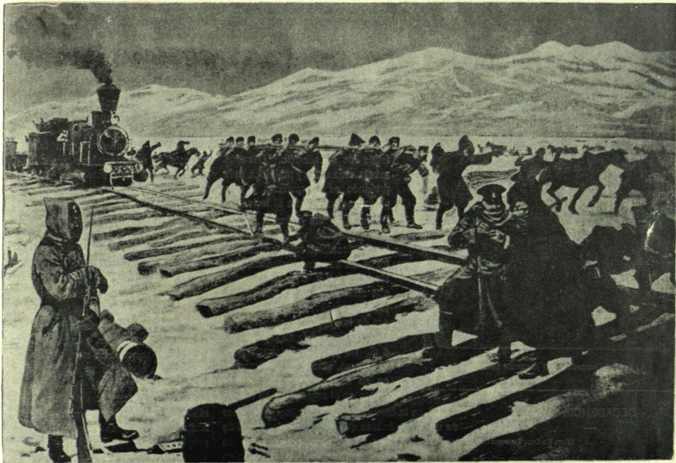
Construcción de una vía férrea sobre el hielo, en el Lago Baikal
