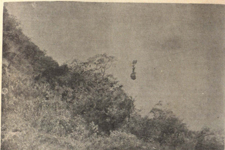
Instalación de Los Naranjos — El cable aéreo
