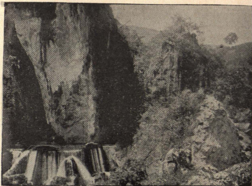
Instalación de El Encantado — Vista del estanque desarenador
