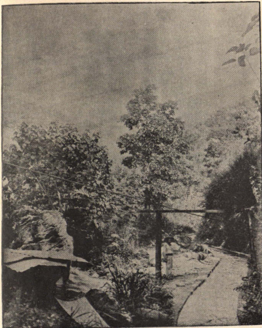
Instalación de Los Naranjos — Vista del canal y de un cable de servicio
