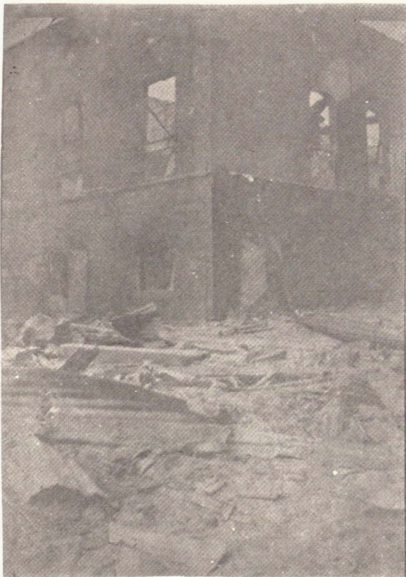
Ruinas de la "Maison Caminade" — Saint-Pierre (catástrofe del 8 de mayo de 1902)
