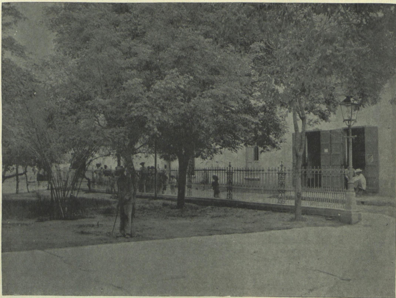
AVENIDA DE BOYACÁ: Barcelona. — De fotografía de Avril
