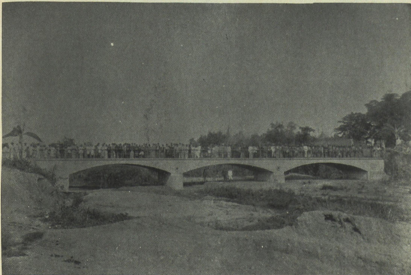
PUENTE TOCUYITO — (Construido por Fernando Loh, ingeniero) — Fotografía de Rey, hijo — Valencia
