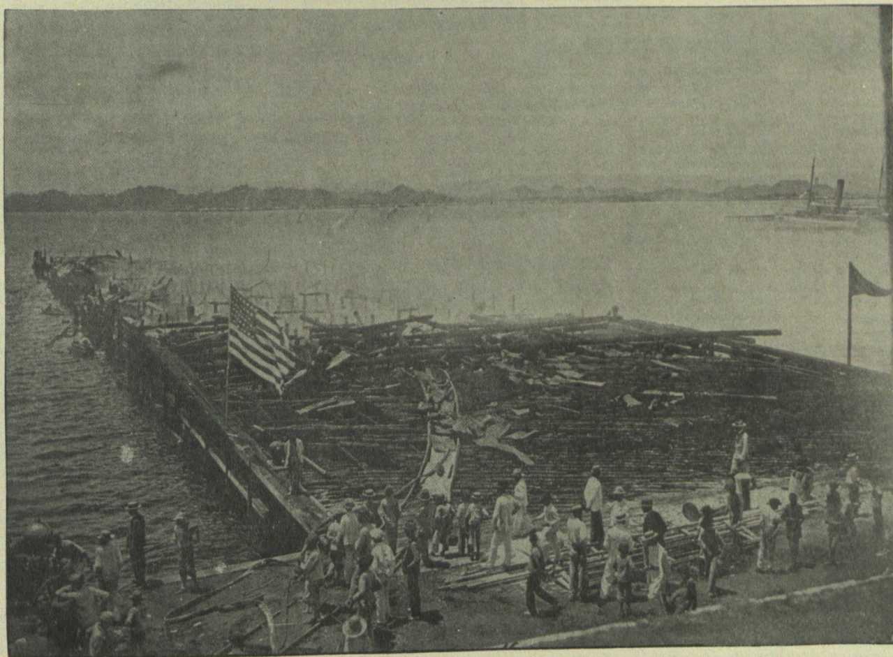
Muelle de Puerto Rico: Al día siguiente del incendio
