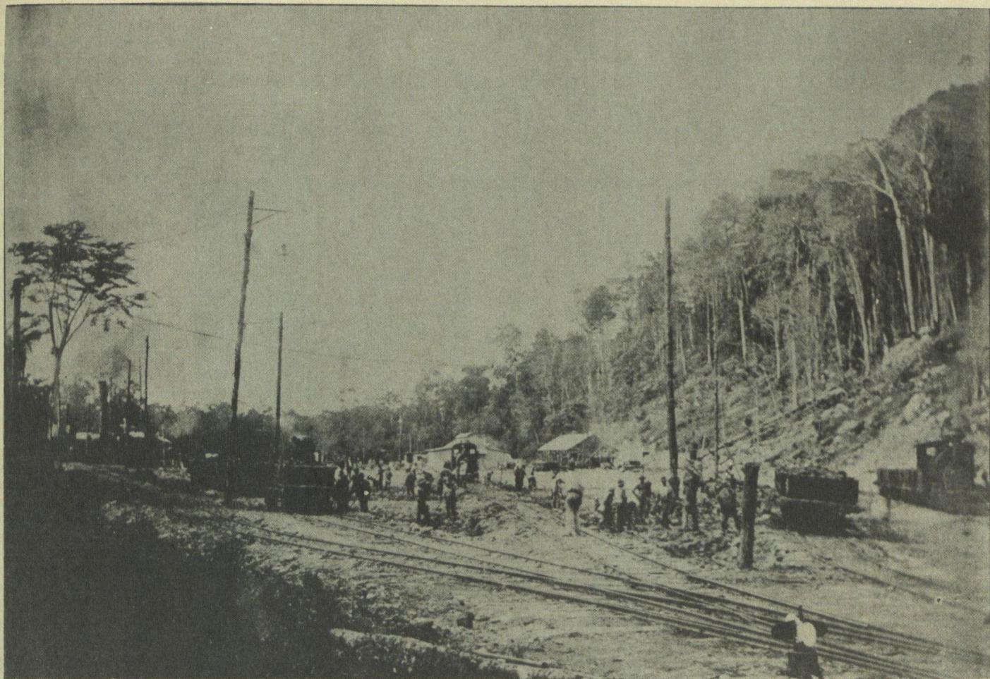
Compañía Bermúdez: Excavación de asfalto en el depósito de embarque
