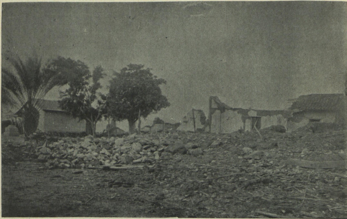
Plaza de Naguayá — (Casas derrumbadas en la Avenida Norte — Terremoto del 29 de octubre de 1900)
