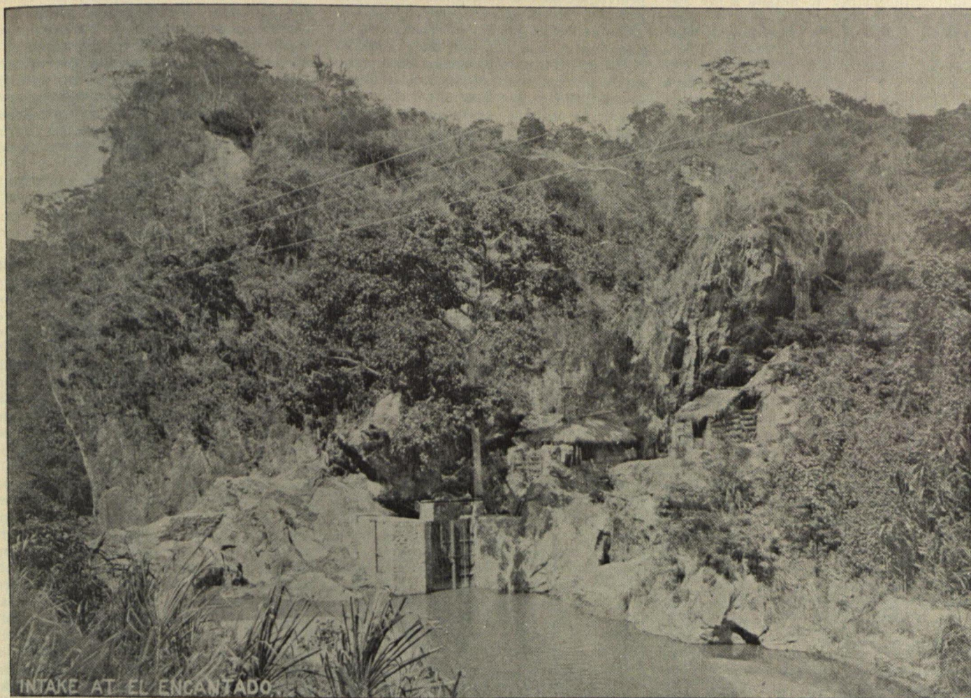
EL ENCANTADO. — La toma de agua para la fuerza eléctrica
