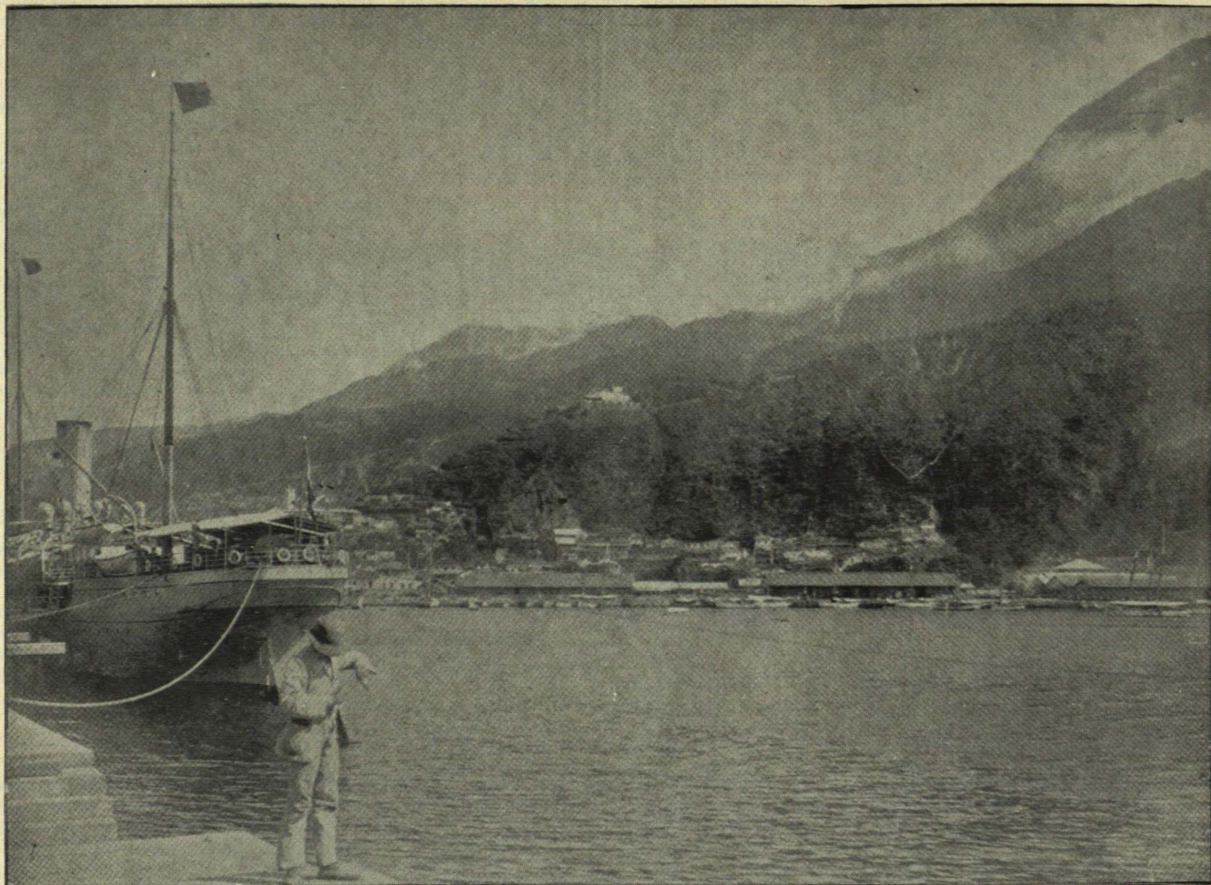
VISTA TOMADA EN EL PUERTO DE LA GUIRA
