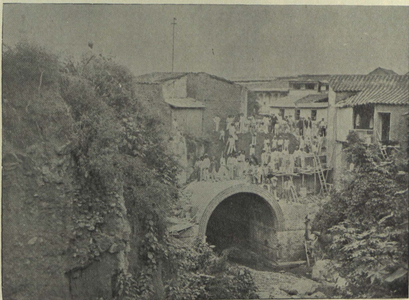
PUENTE AL NORTE DE EL ABANICO
