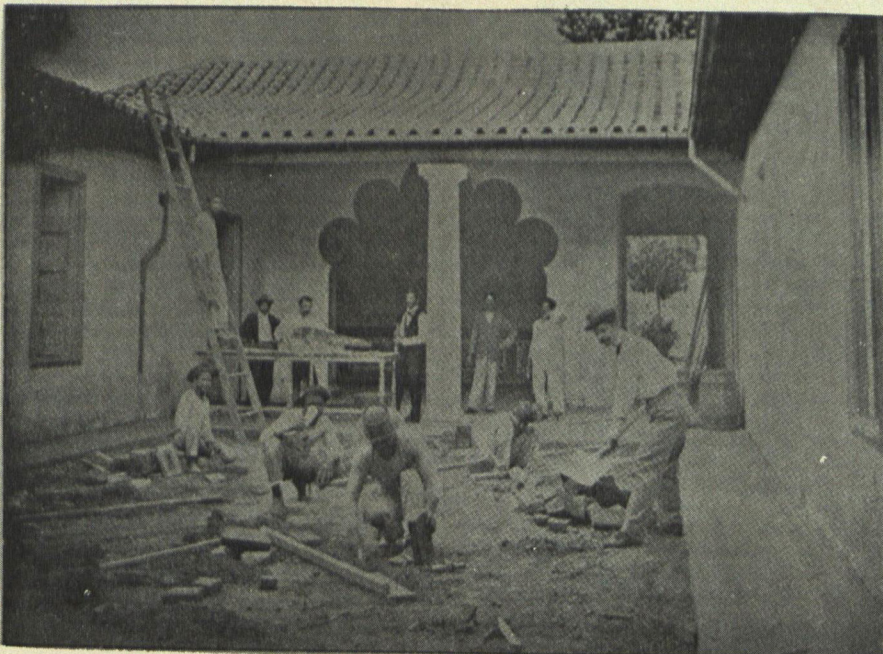
Maracay: casa en construcción (del señor Ernesto De Jongh) — De fotografías del señor Julio E. González
