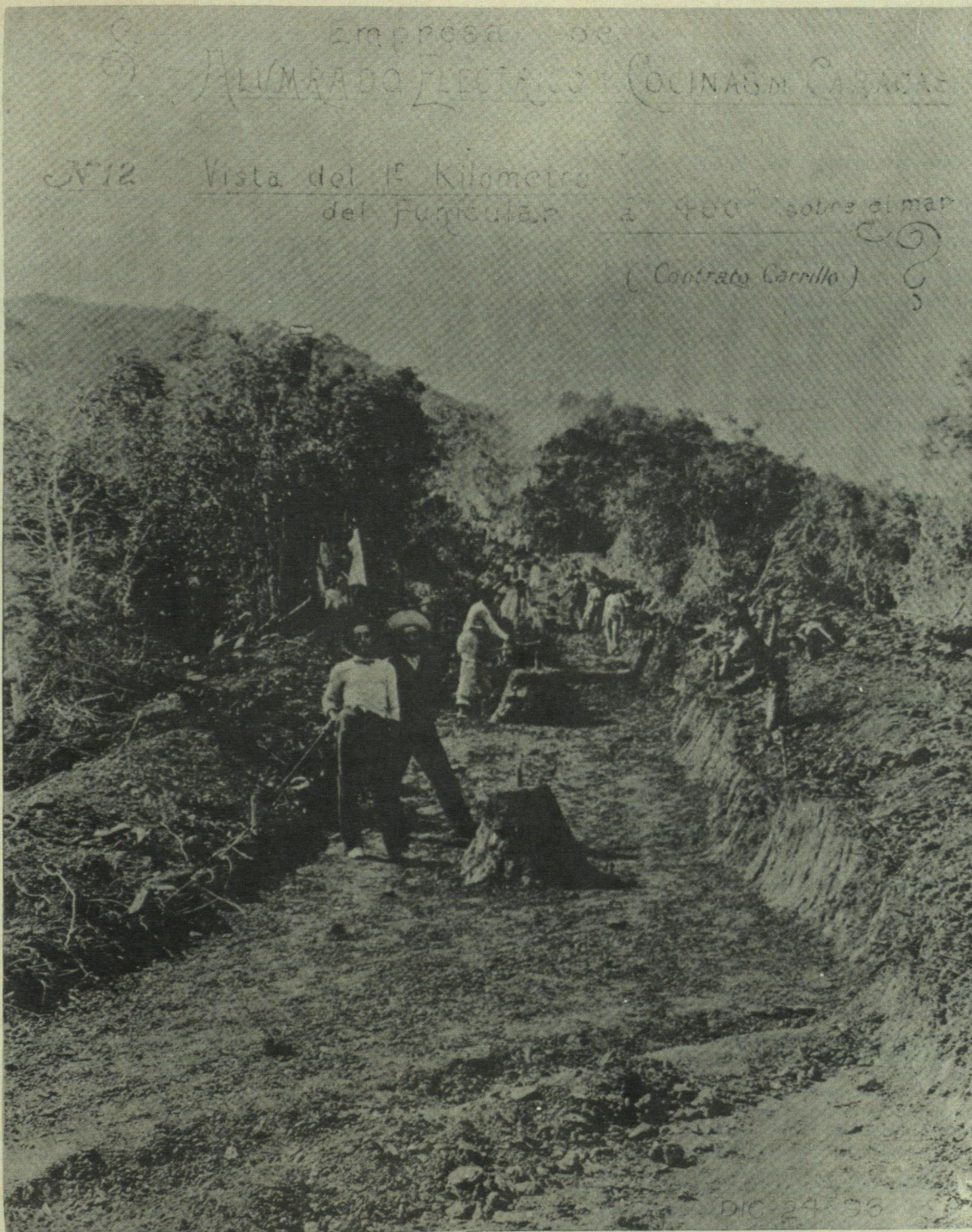
MACUTO. — TRABAJOS PARA EL FUNICULAR.
