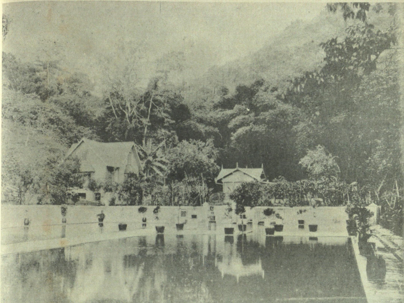
MARAVAL — LA CAJA DE AGUA. — Puerto España, Trinidad
