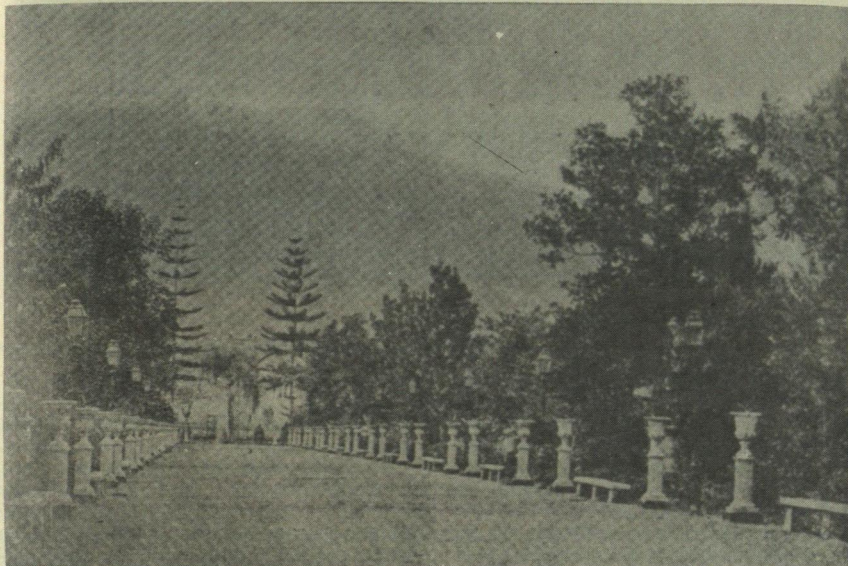
ALAMEDA DE LOS DESCALZOS—Lima
