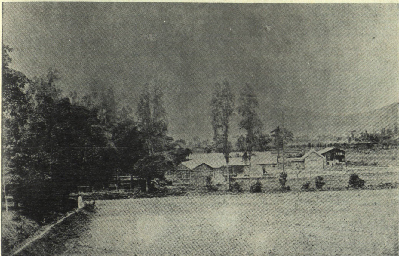
VISTA TOMADA Á LA SALIDA DEL PUENTE DE HIERRO. — (Fotografía de Schael)
