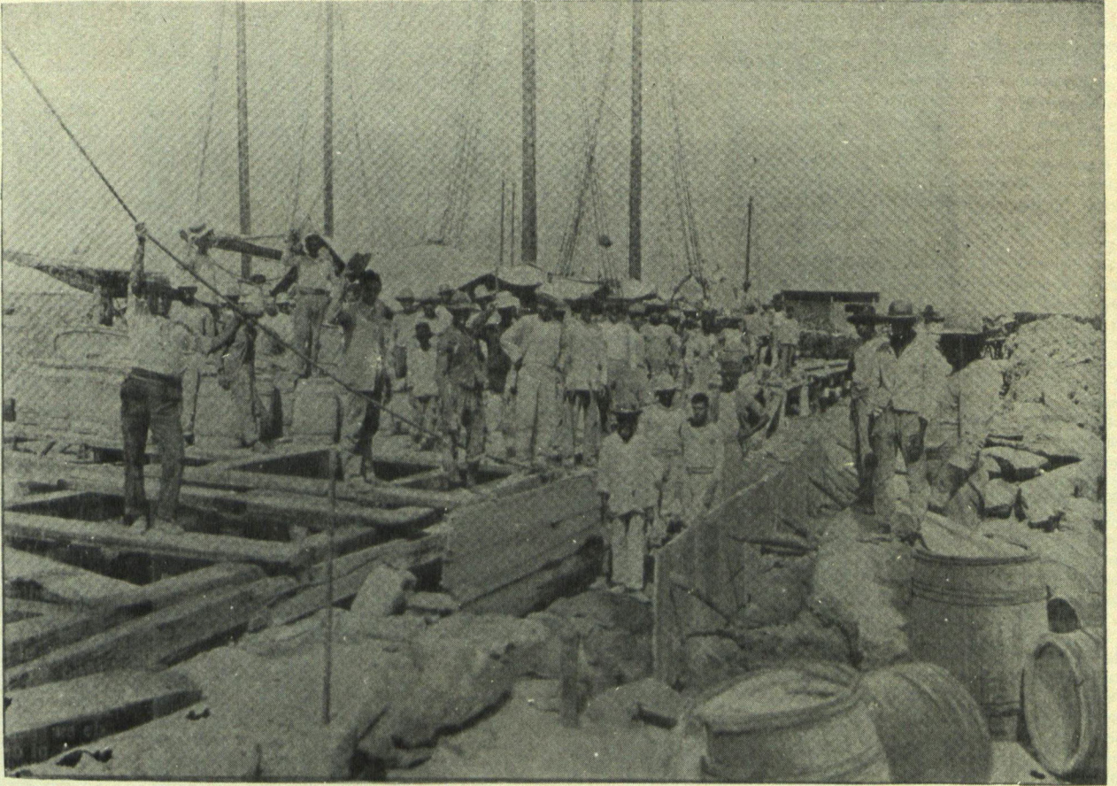
Construcción del muro posterior
