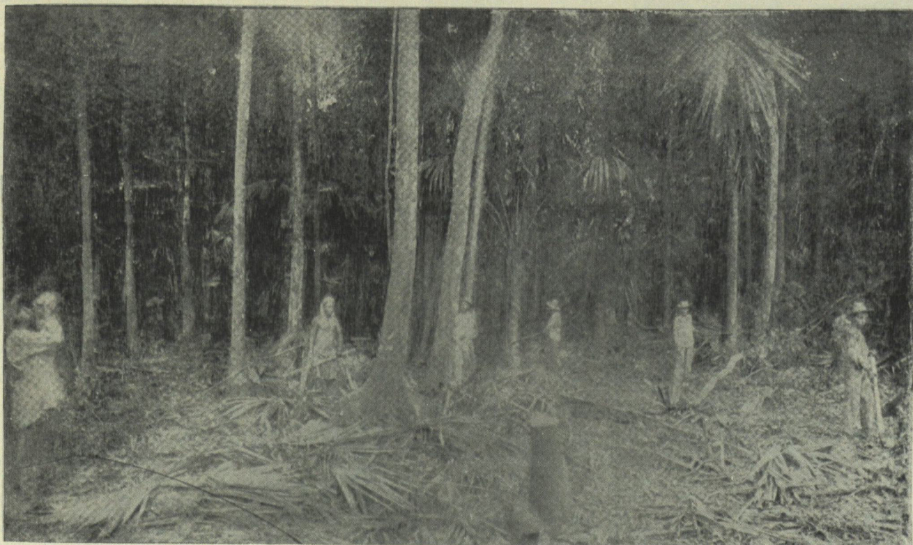
DESMONTE A ORILLAS DEL ESCALANTE [Zulia]
