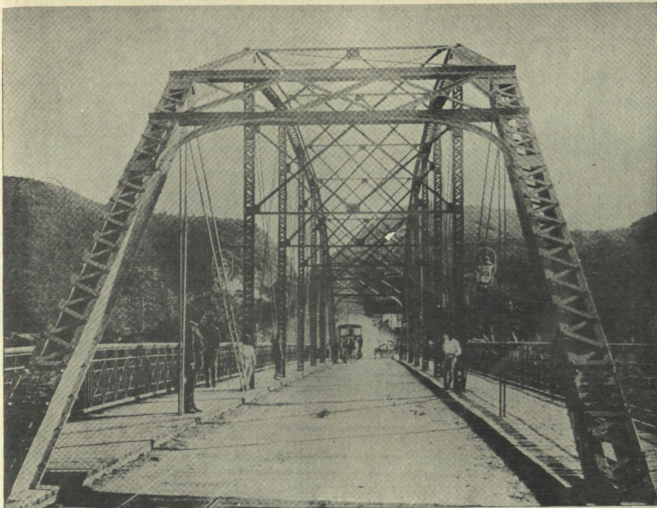
NUEVO PUENTE SOBRE EL GUAIRE—(Al término de la calle Sur 7)—(Fotografía de Lessmann)
