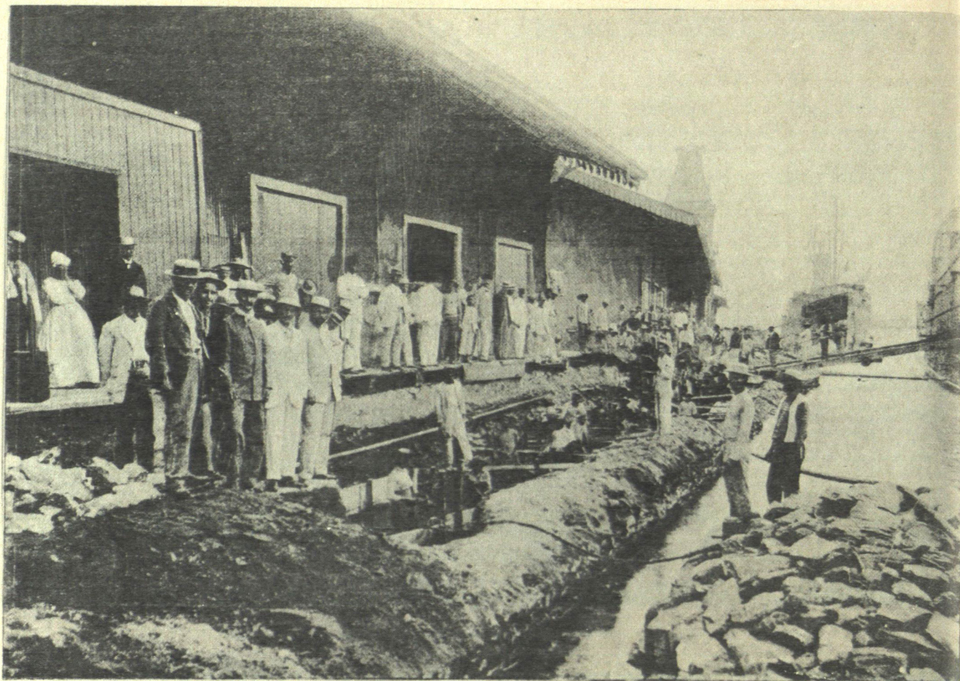
MUELLES DE PTO. CABELLO EN CONSTRUCCIÓN.—(De fotografía del señor Rey, hijo)
