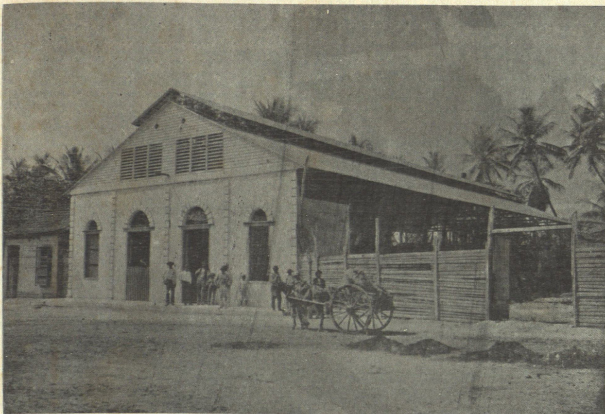
VISTA EXTERIOR DEL EDIFICIO
