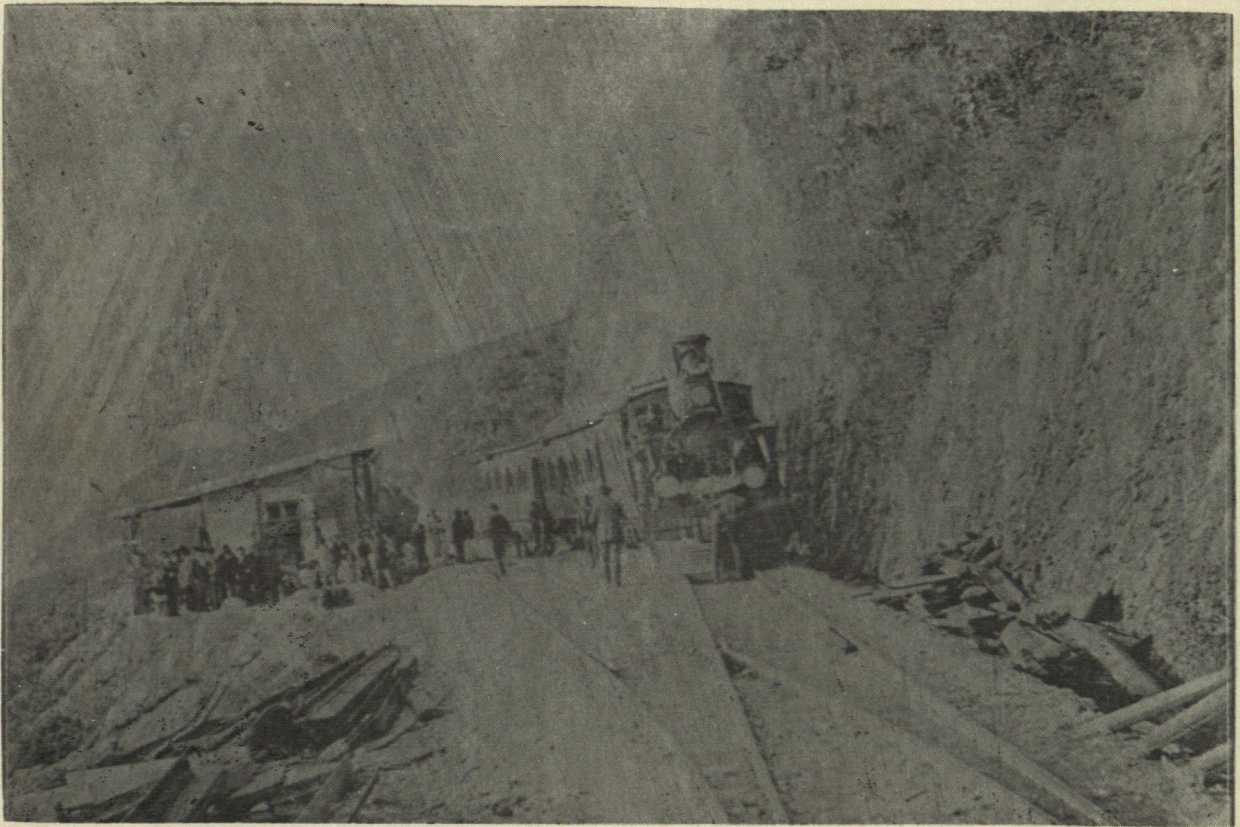
GRAN FERROCARRIL DE VENEZUELA — ( EL CABLE — KILÓMETRO 55 )
