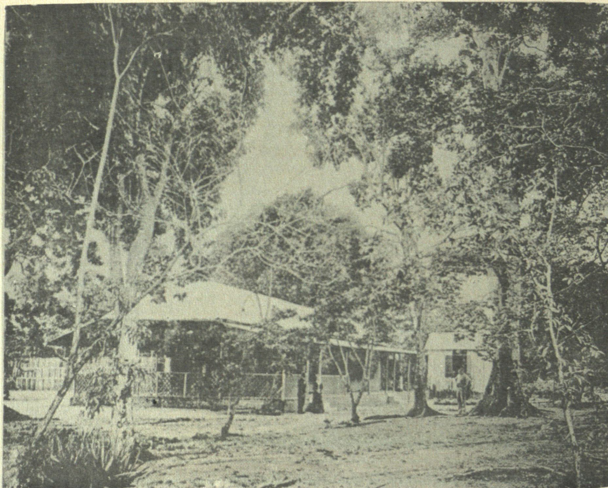
EDIFICIO DE LA EXTINGUIDA FÁBRICA DE DINAMITA—CIUDAD BOLIVAR
