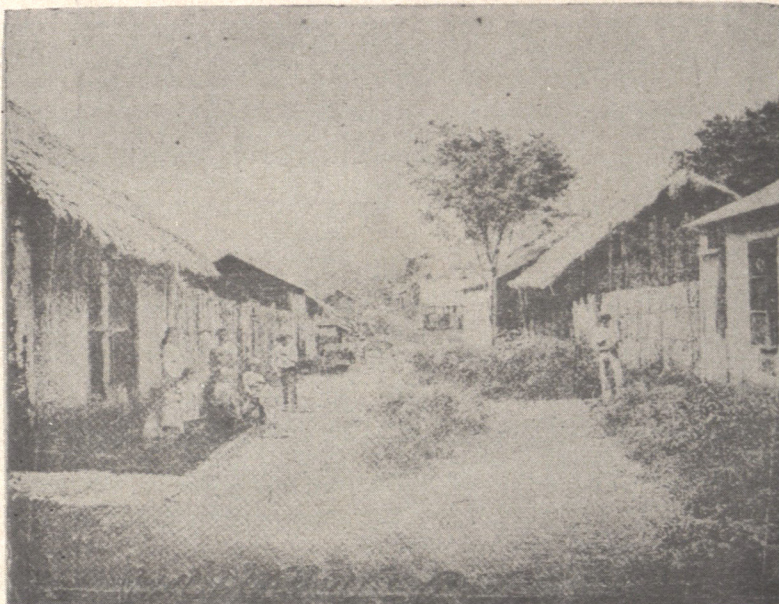
Entrada á Guasipati
