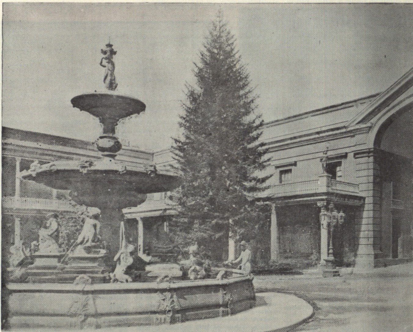
CENTRO DEL PATIO DEL PALACIO FEDERAL
