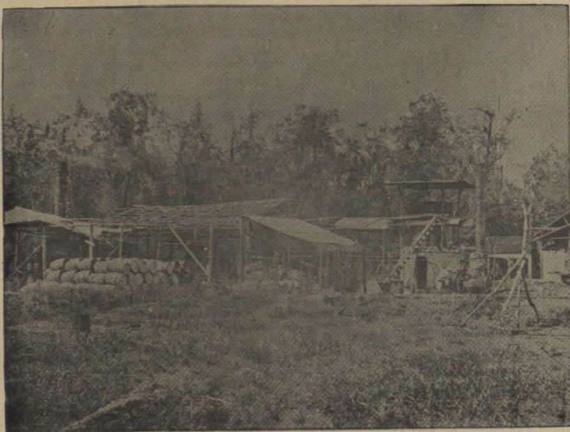
PEDERNALES. — Edificio de los Alambiques
