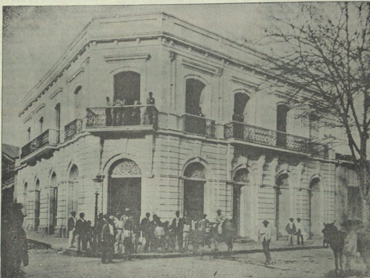
Nuevo edificio construido en la esquina del Padre Sierra, bajo la dirección del arquitecto señor Hurtado Manrique Propiedad del señor M. Arteaga Revenga.
