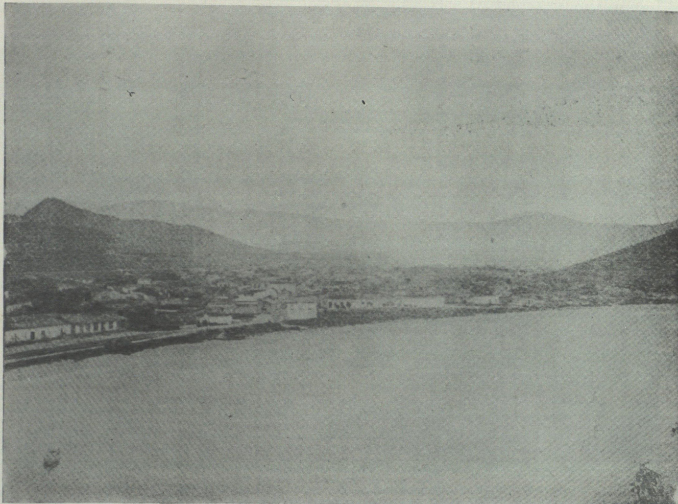
VISTA GENERAL DE CARUPANO, TOMADA DEL PUERTO
