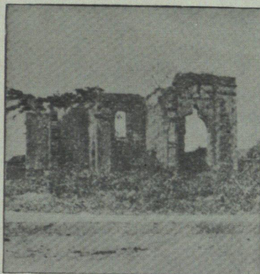
RUINAS DEL SOCORRO. — Valencia
