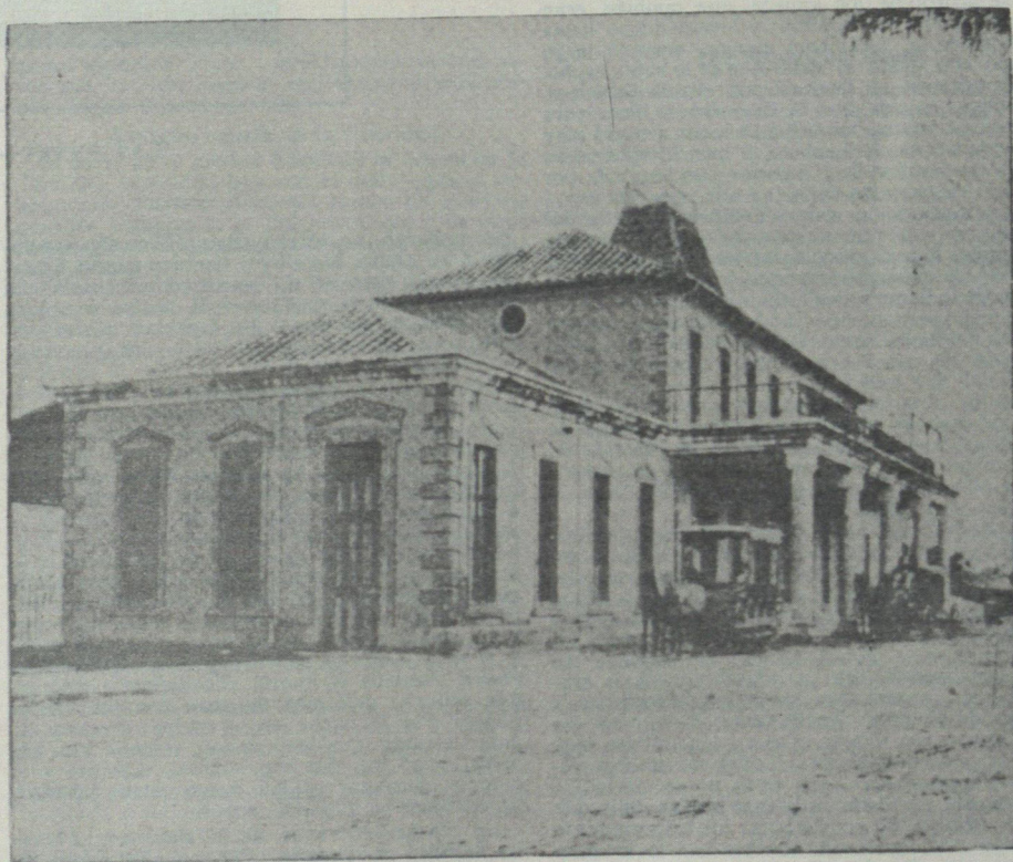
ESTACIÓN DEL FERROCARRIL CENTRAL — Caracas
