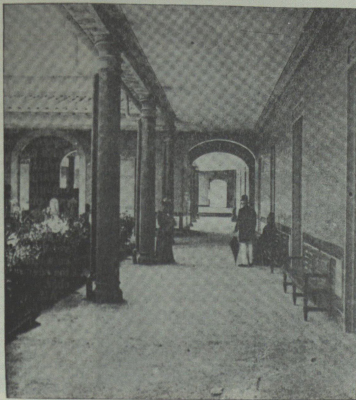
HOSPITAL DE NIÑOS — Corredores al Este del edificio
