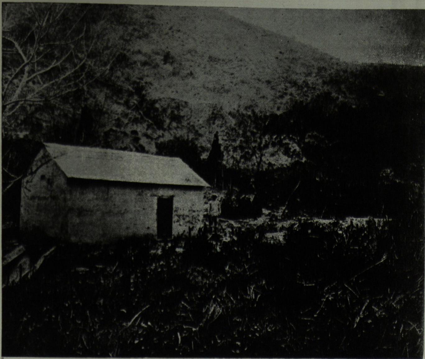
ACUEDUCTO DE BARQUISIMETO — VISTA DE LA TOMA POR SU FRENTE
