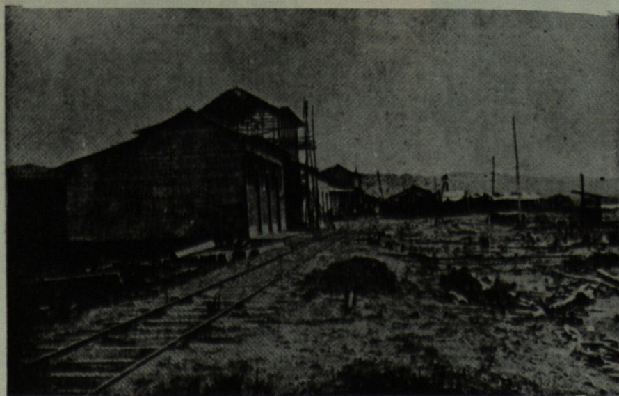
CARENERO — VISTA DE SUR A NORTE
