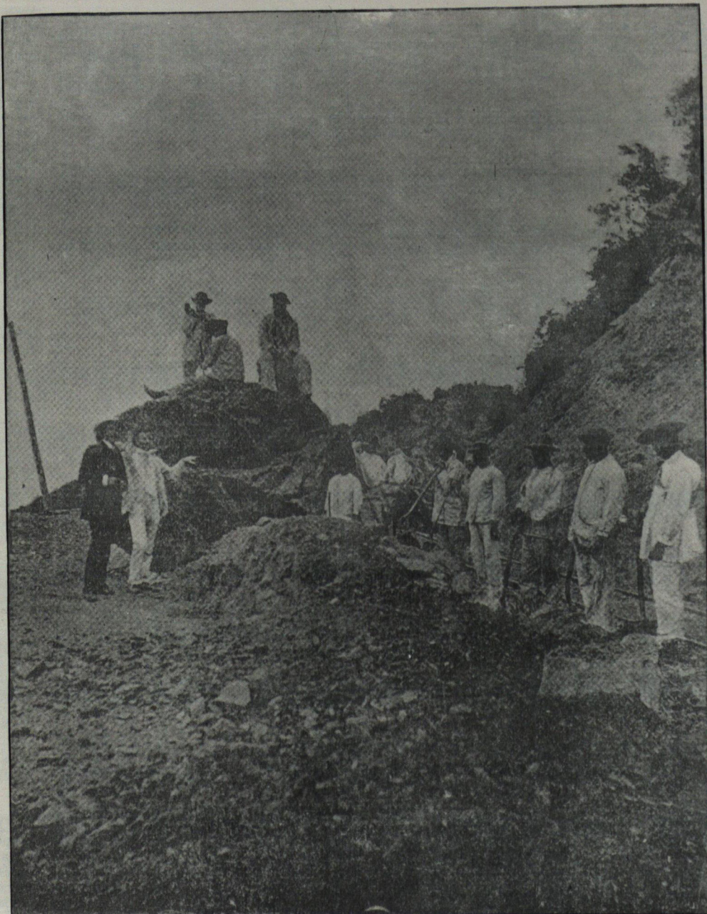
DERRUMBAMIENTO EN EL CAMINO DEL FERROCARRIL DE LA GUAIRA Á CARACAS
