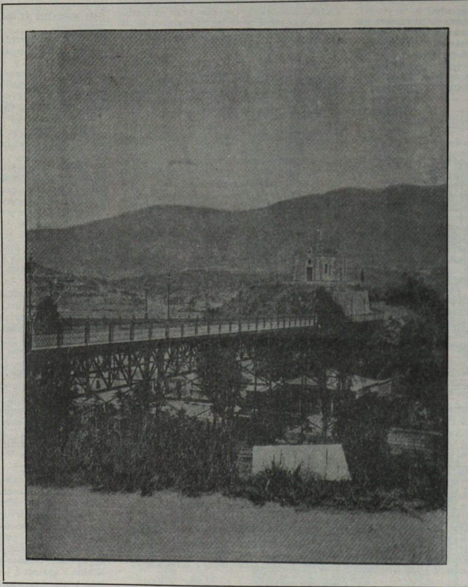
VIADUCTO DE LA IGLESIA DE LOURDES A LA DEL CALVARIO
