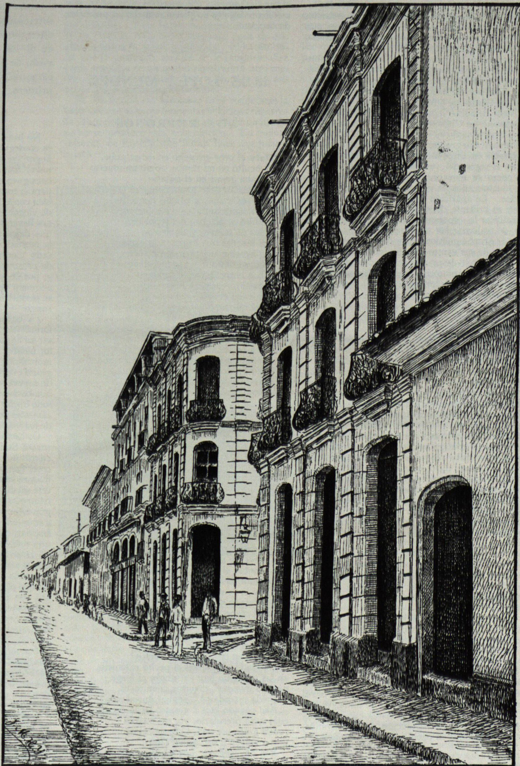
ENTRADA AL PASAJE LINARES (VISTA SUR)
